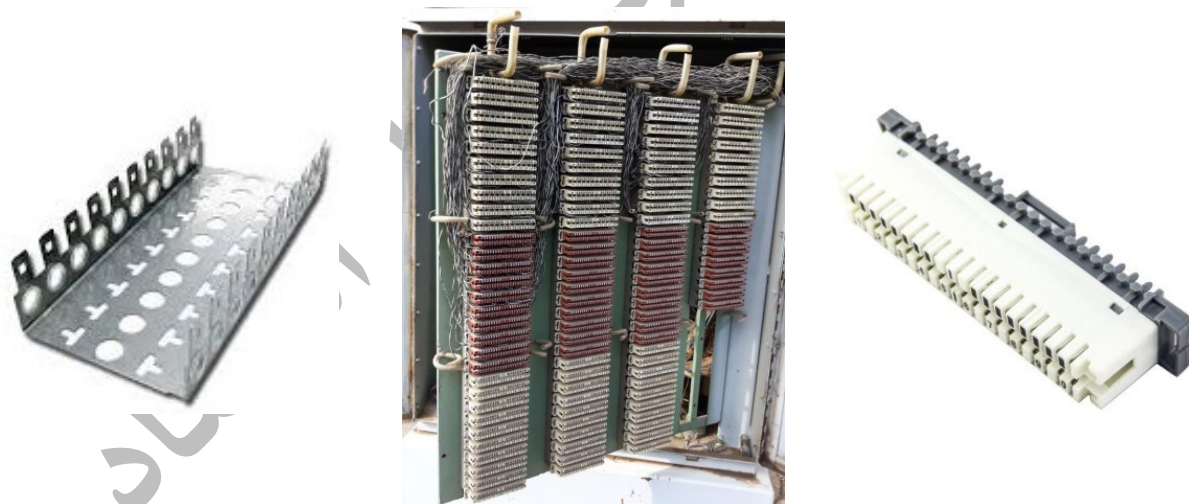
شکل ۹-۱- ترمینال ۱۰ زوجی، دسته‌های ۱۰۰ تایی و پایه ترمینال کروز
