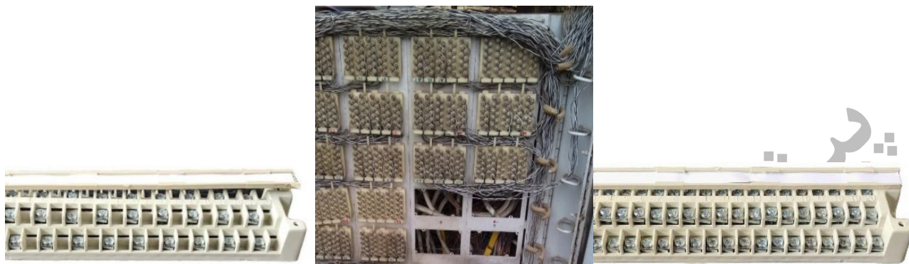
شکل ۸-۱- ترمینال‌های ۲۰، ۲۵ و ۱۰ زوجی پیچی
